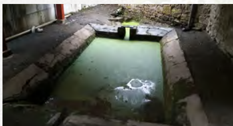
Le lavoir avant travaux
