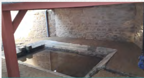
Le lavoir après travaux
